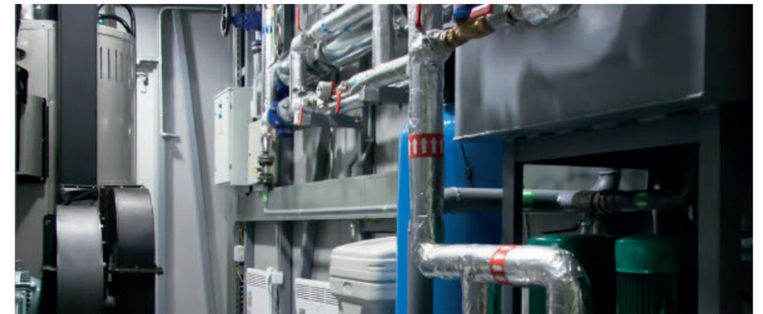
Котельная комплектуется линией подачи топлива, наличие того или иного оборудования зависит от вида топлива — газ природный/сжиженный или дизель, в частности, для котлов на дизельном топливе предусматривается расходный бак дизельного топлива с автоматической системой отслеживания уровня топлива в баке.
