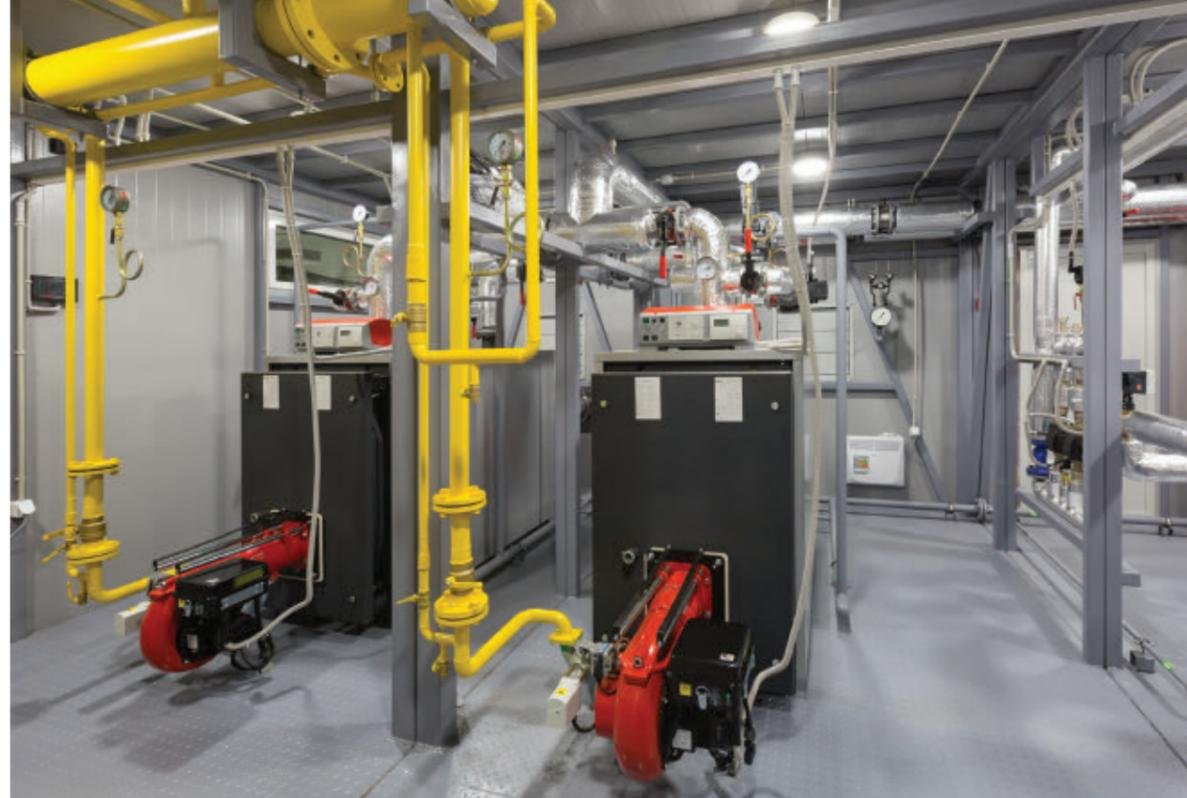
Общий вид котлов марки UNICAL, модель Ellrhex 630, с горелочными устройствами марки F.B.R., модель GAS 70/MCE (модулируемая, топливо – природный газ)
