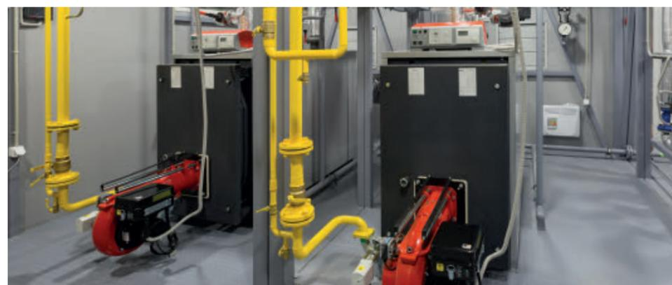
Каждая котельная укомплектована приборами учета – топлива, тепла, воды на входе в котельную, электроэнергии. По желанию заказчика показания приборов можно вывести на удаленный компьютер диспетчера.
