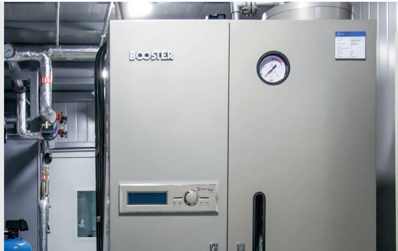
Котел марки Booster Фронт котла BSS 1500 SD (дизель)
