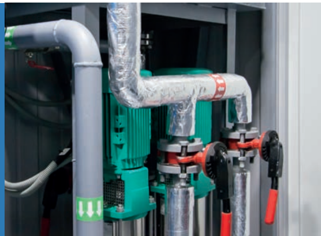
Блок питательных насосов (рабочий, резерв)
