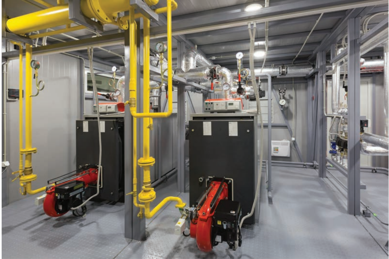
Общий вид котлов марки UNICAL, модель Ellrrex 630, с горелочными устройствами марки F.B.R., модель GAS 70/MCE (модулируемая, топливо – природный газ)
