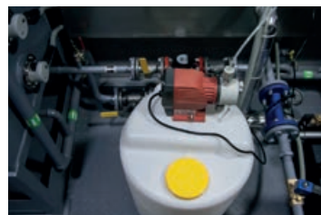
Дозирующий насос с ёмкостью для химикатов
