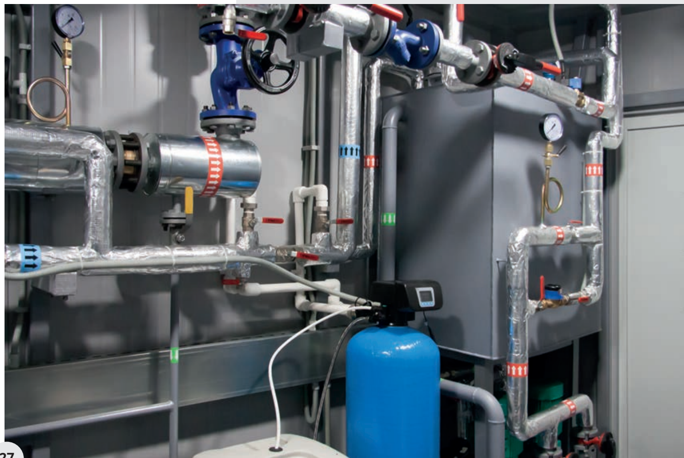
Питательный бак котельной, ёмкостью 500 л
